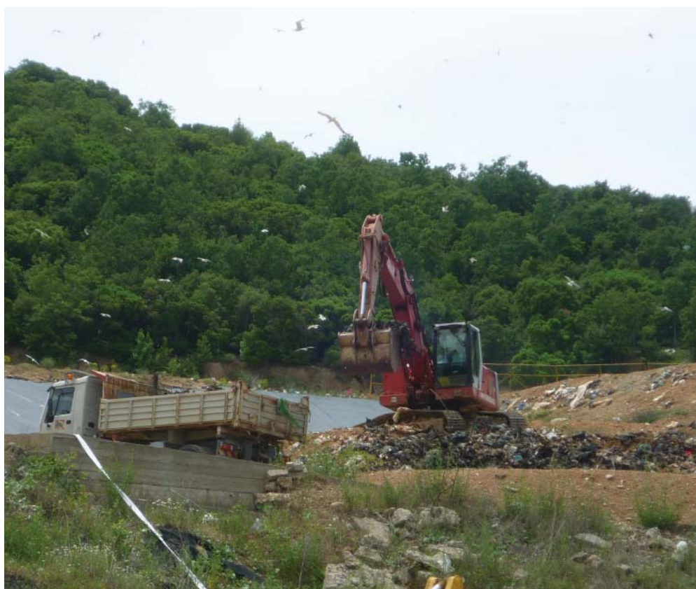
Εξόρυξη Αποβλήτων στο ΧΥΤΑ Πολυγύρου / The LFM Process in Polygyros Landfill
